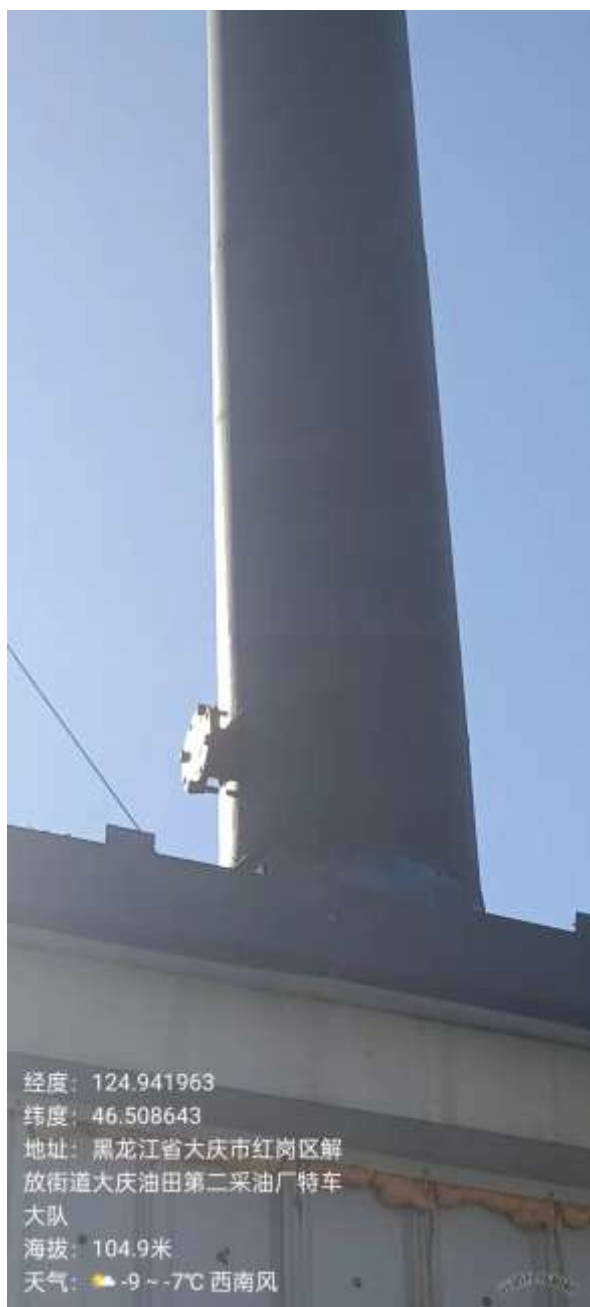
特车大队综合队锅炉房 1#锅炉烟囱采样口
