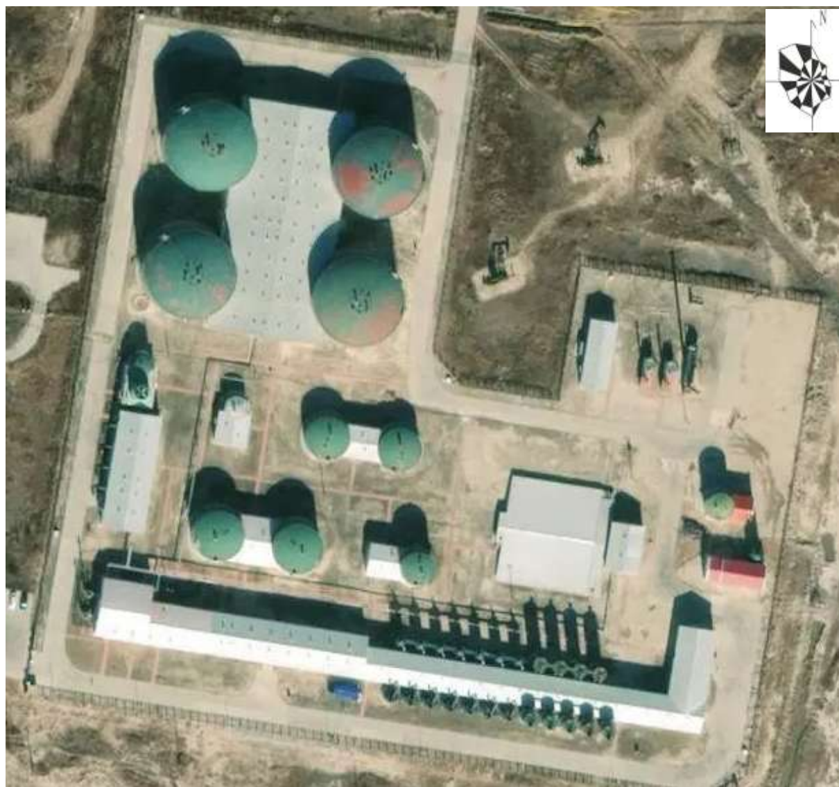
南二十三注水变电队
