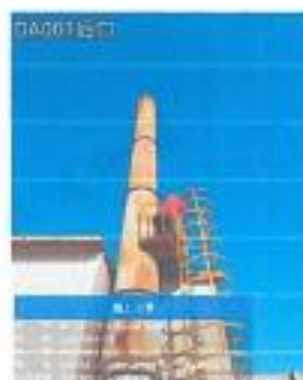
排气筒 (DA001) 处理后
