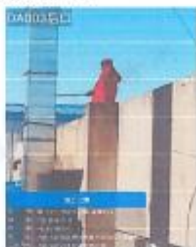
排气筒 (DA003) 处理后
