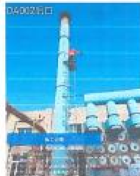
排气筒 (DA002) 处理后
