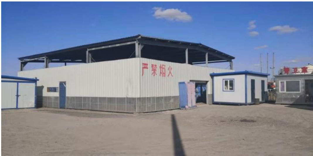
朝一联废压裂液处理站现状
