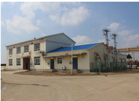
朝一联合含油污泥处理站厂房及加药间现状
