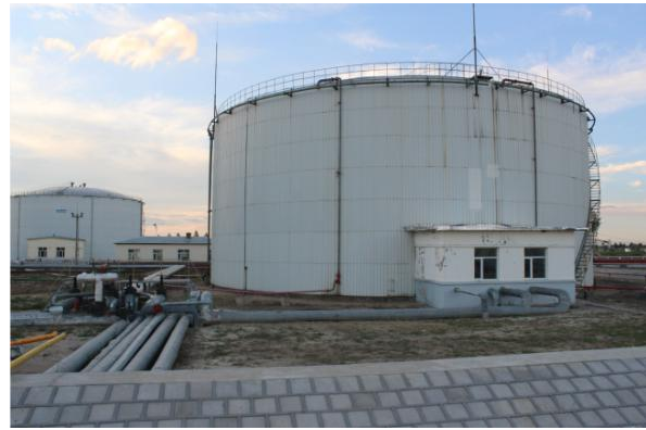
朝一联合站原油脱水站罐区现状
