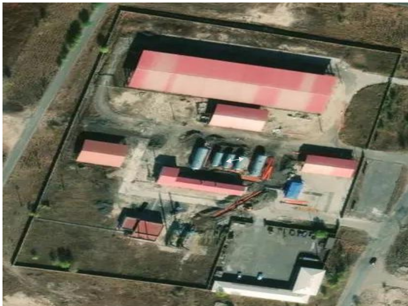
第四作业区含油污泥处理站
