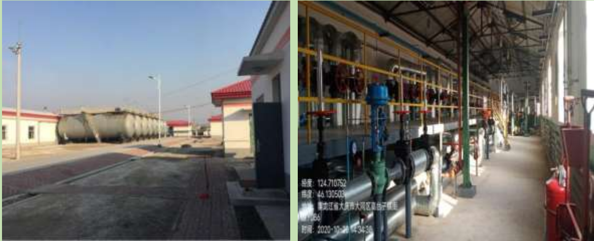
图 3.10-7 高一联脱水站站况现状
