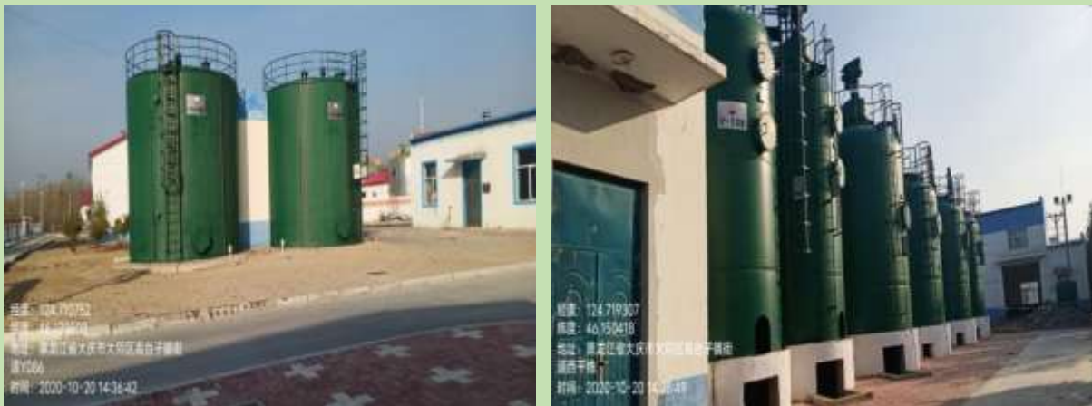
图 3.10-9 高一联含油污水处理站现状图
