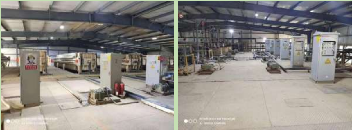
图3.10-17 废弃泥浆无害化处理中心现状图
