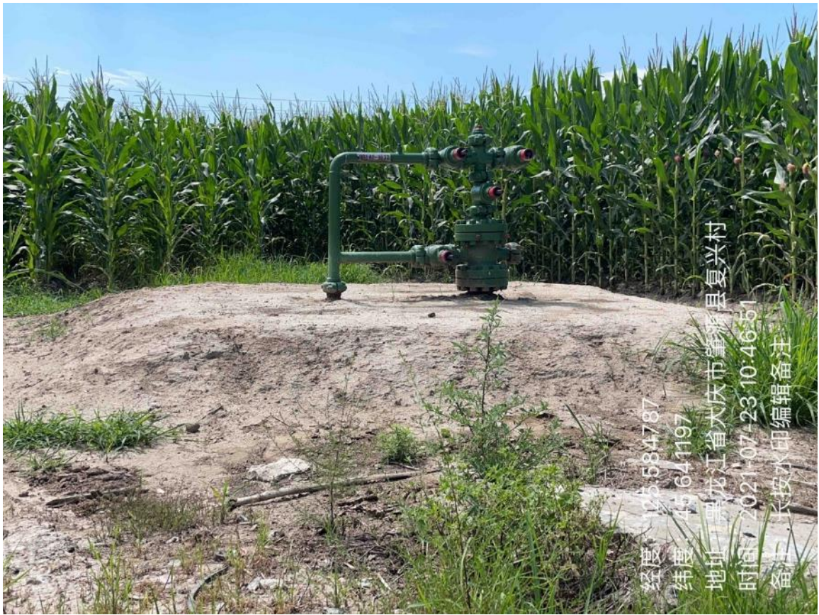
朝 142-斜 32 井建设情况 (水井)
