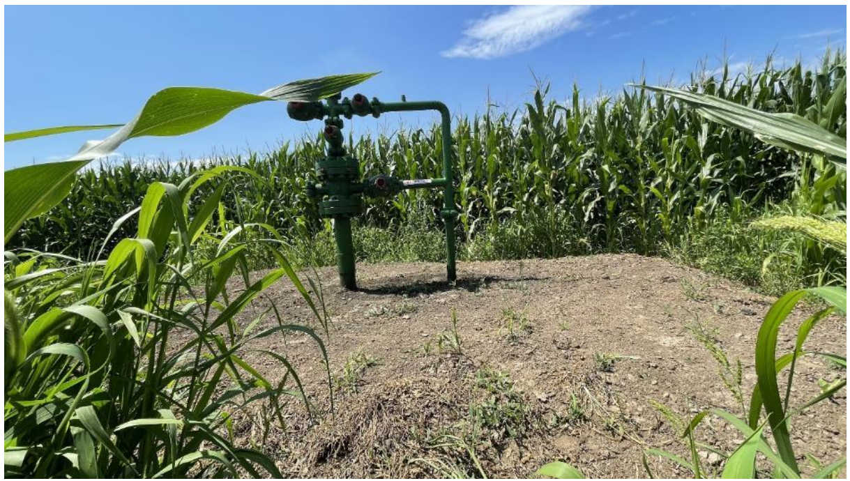
朝 134-38 井建设情况（水井）
