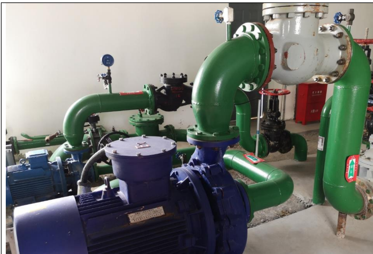
朝 4 转油站更新掺水泵
