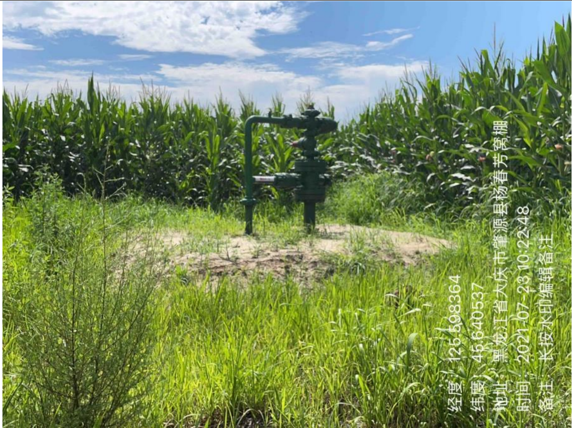
朝 64-5 井建设情况（水井）
