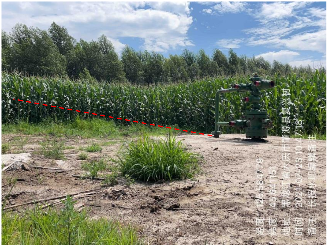
朝 142-斜 32 井场周边及管线周边生态恢复情况
