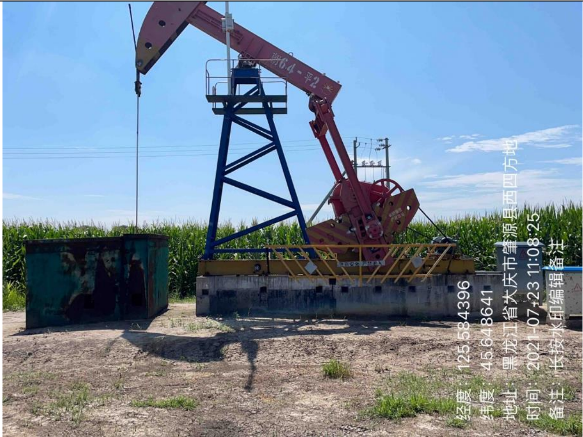
朝 64-平 2 井建设情况（抽油机井）
