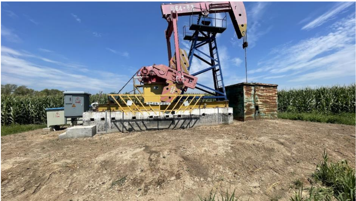
朝 64-平 3 井建设情况（抽油机井）
