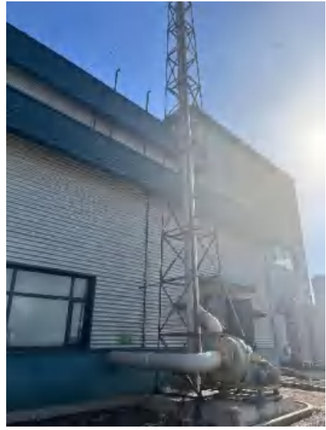
二车间排气筒
