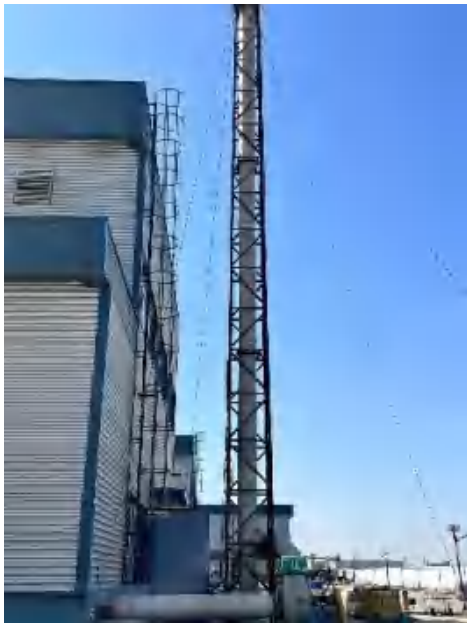
三车间排气筒
