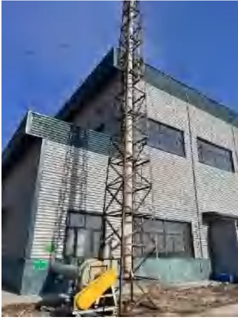
一车间排气筒
