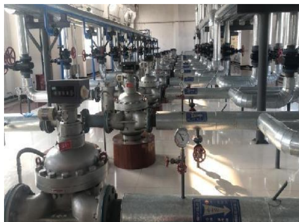
宋一联脱水站泵房现状
