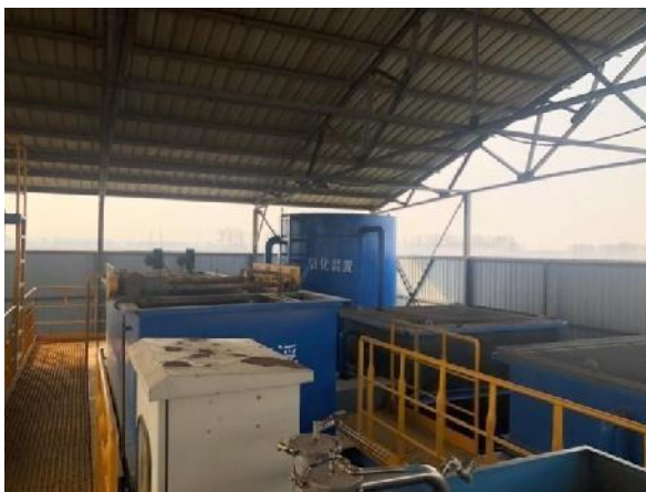
宋二联合站压裂废液处理站氧化装置
