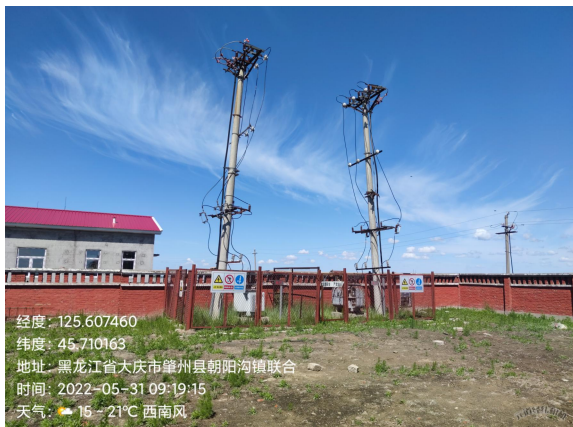
厂区西北方向现状
