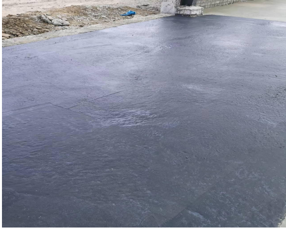
施工期防渗影像
