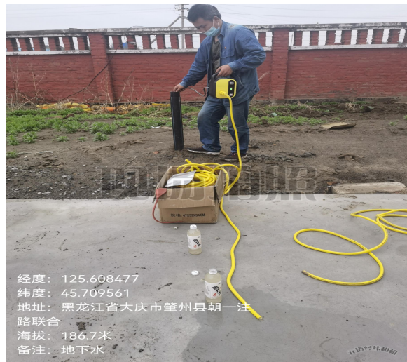
依托污泥站内监测井现状
