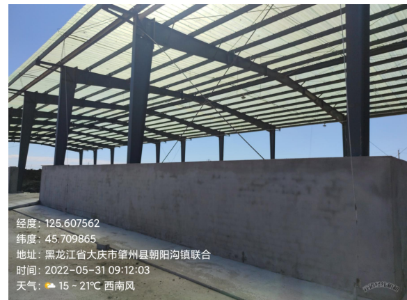
新建混凝土围墙现状
