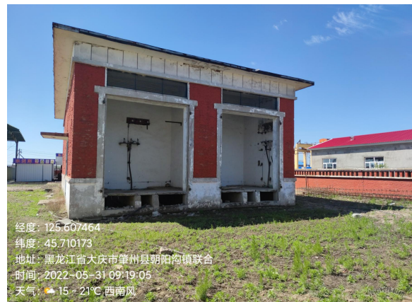
拆除配电柜现状
