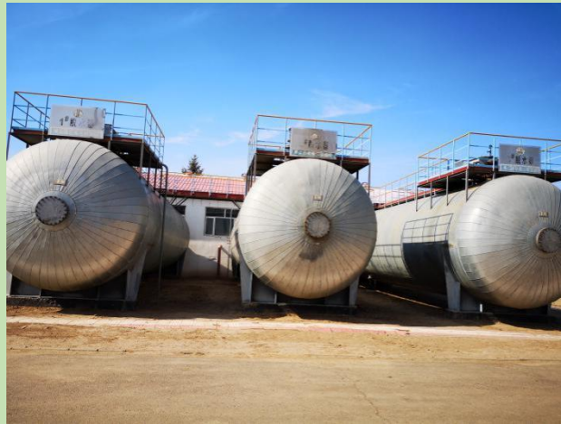
图 3.10-5 朝一联脱水站站内现状
