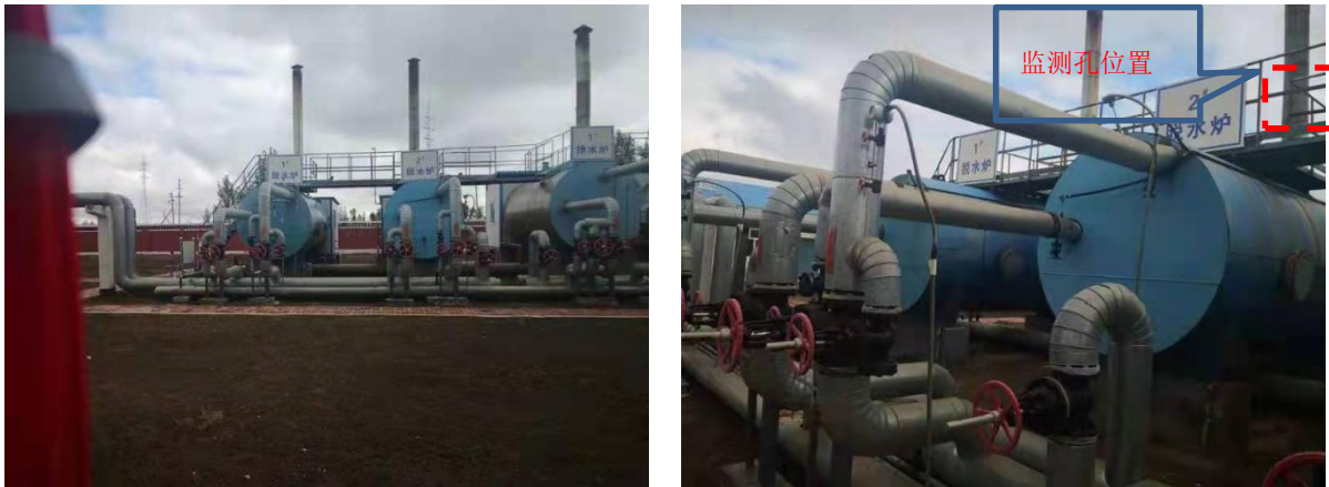
图 4-7 朝六联转油脱水站加热装置区现状
