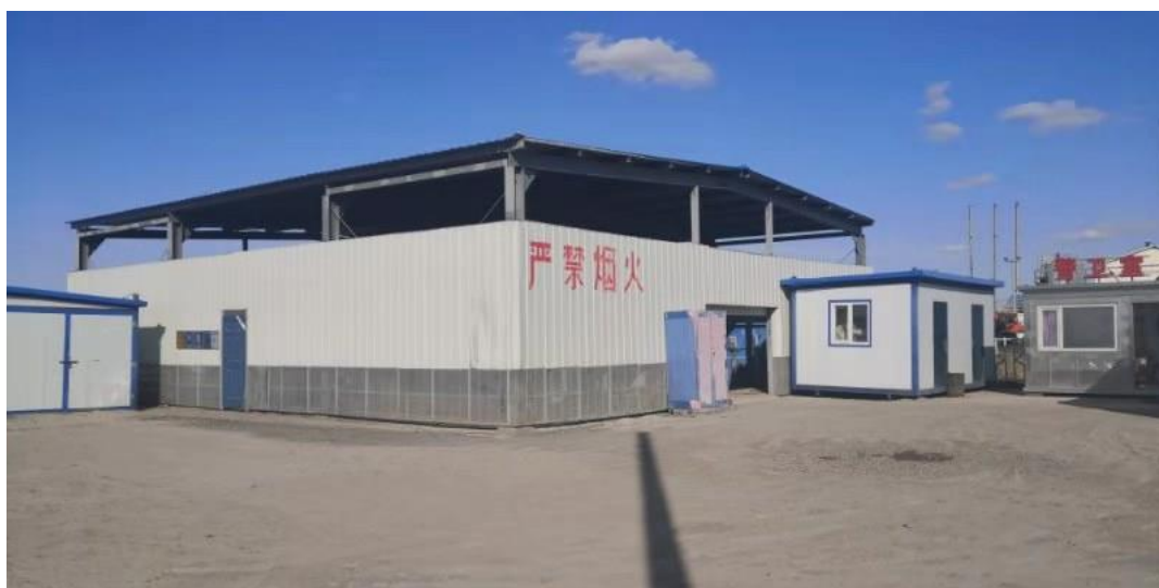
图 4-14 朝一联废压裂液处理站现状
