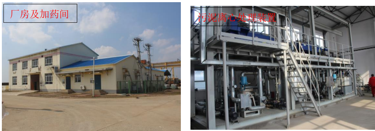
图 4-12 朝一联合含油污泥处理站现状
