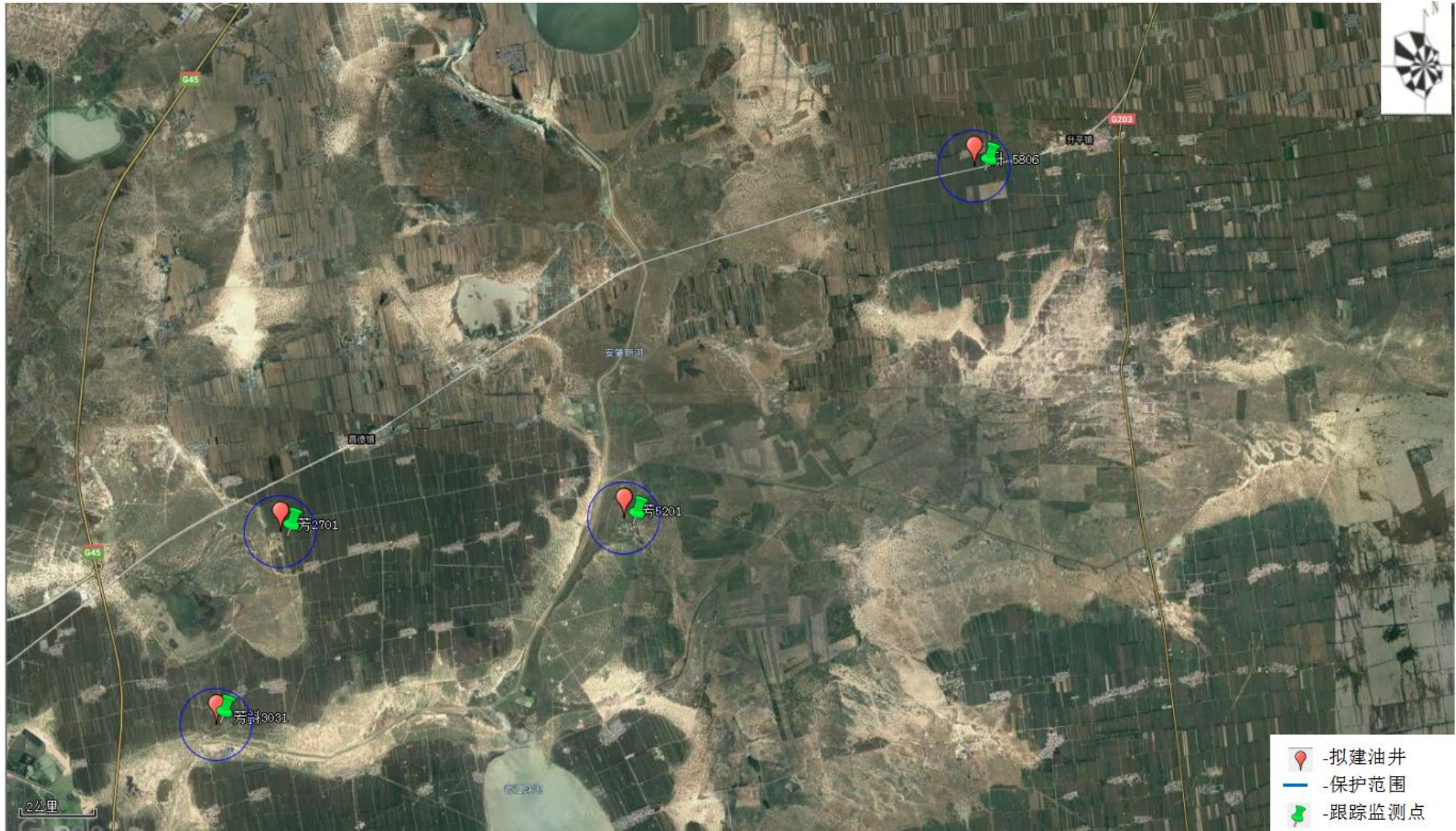
图5.6-1 土壤跟踪监测井
