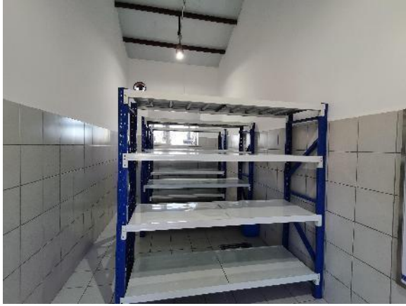
其他危险废物存储库内现状
