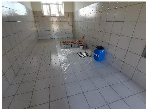
废电瓶存储库内现状
