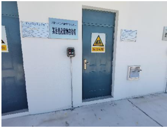
其他危险废物存储库
