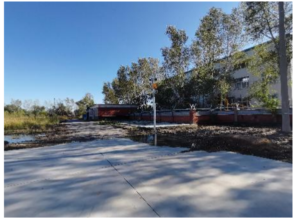
厂区西南角监控
