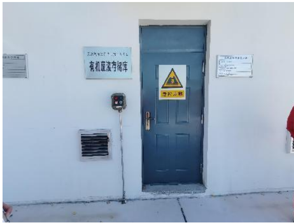
有机废液存储库
