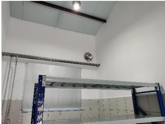
毒害品存储库内现状
