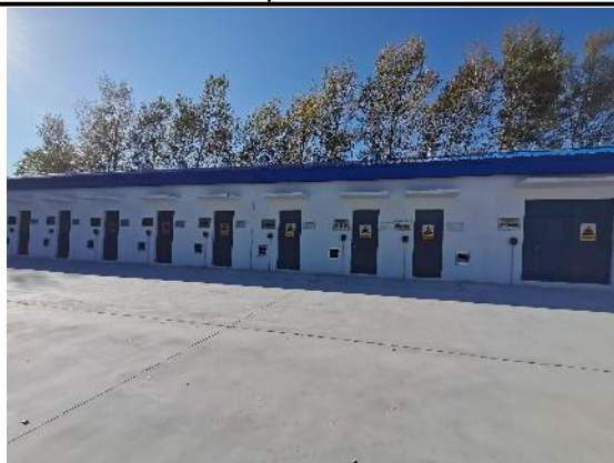
新建危险废物存储库
