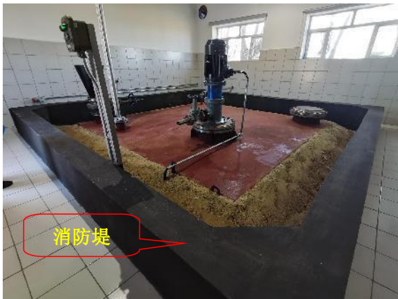
废机油存储库现状
