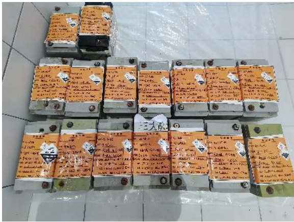
本项目储存废电瓶现状
