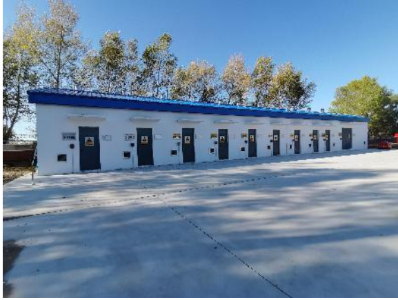
危险废物存储库房现状
