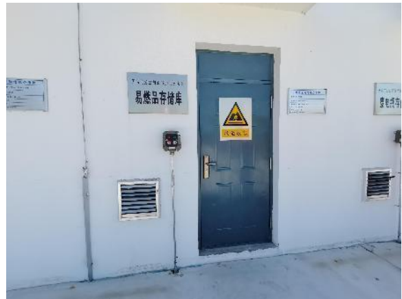
易燃品存储库
