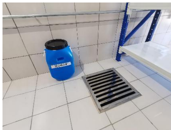
废腐蚀品存储库收集池
