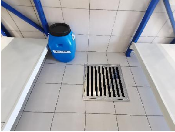
其他危险废物存储库收集池
