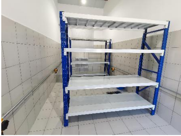
腐蚀品存储库内现状
