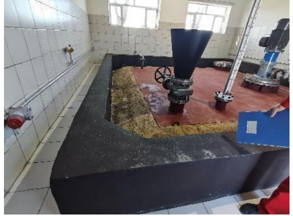
废机油存储库内现状
