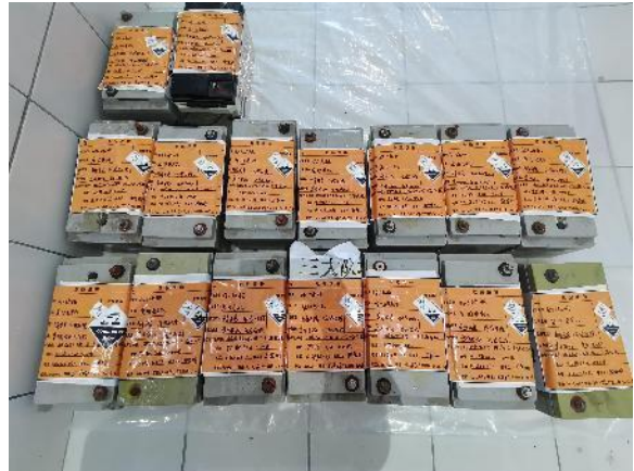
存储废电瓶现状
