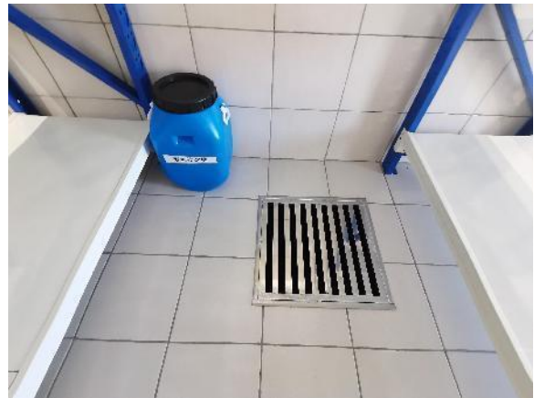
存储库设置收集池
