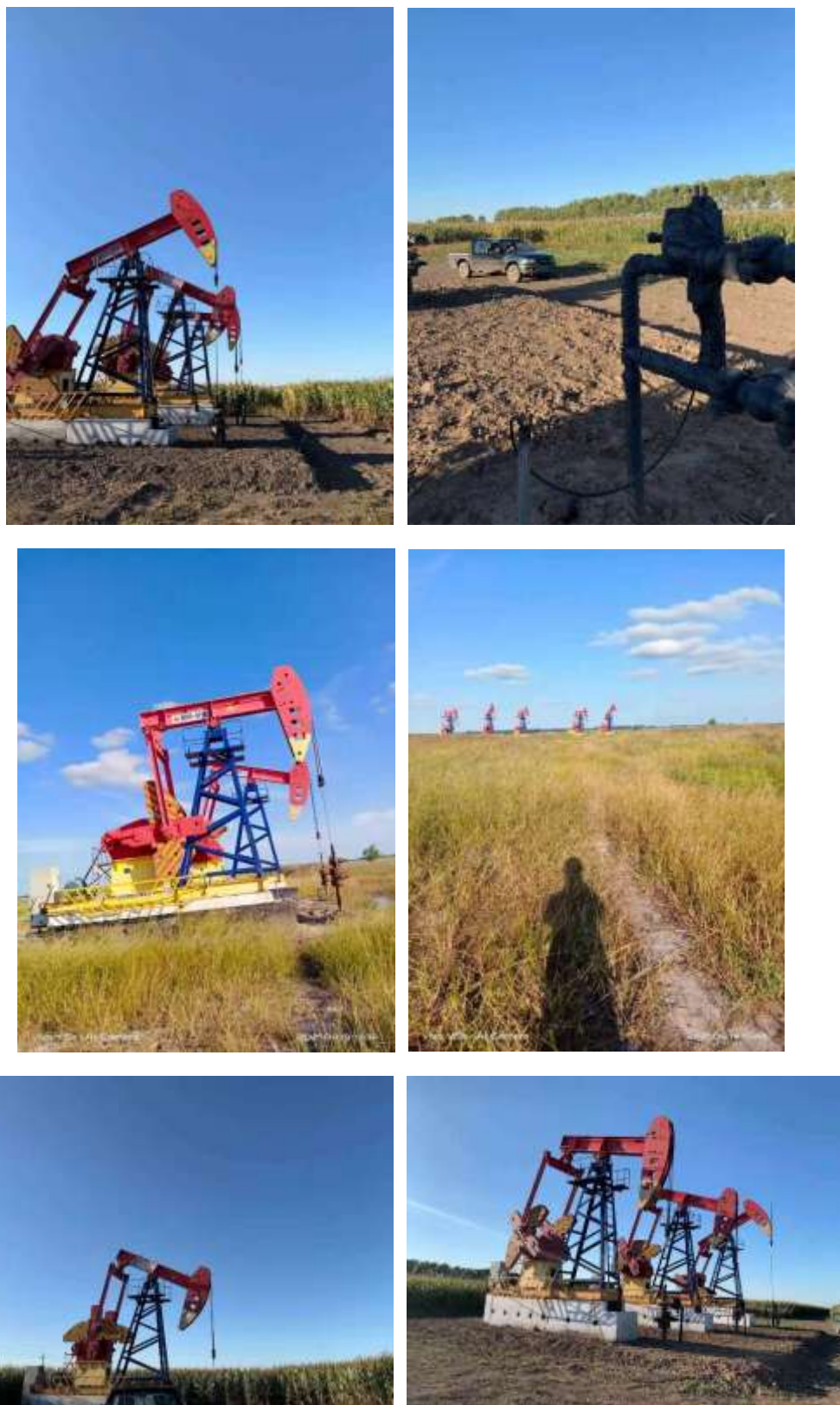
图3.1-1 榆东地区现有井场周边生态恢复情况
