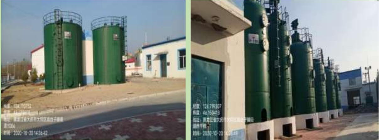
图 3.9-9 高一联含油污水处理站现状图
