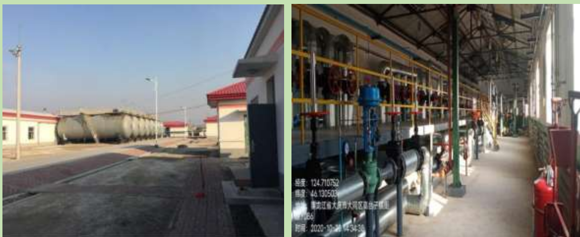
图 3.9-7 高一联脱水站站内现状
