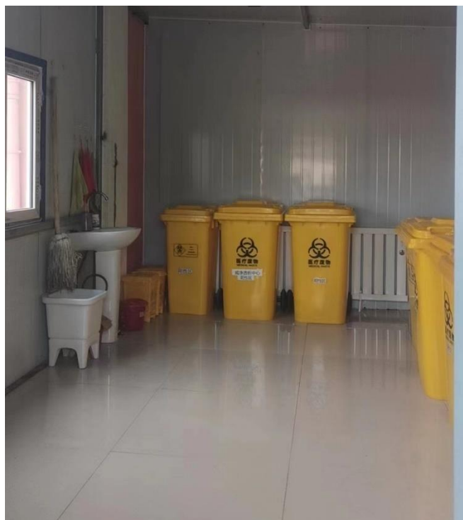
医疗废物暂存间地面防渗照片
