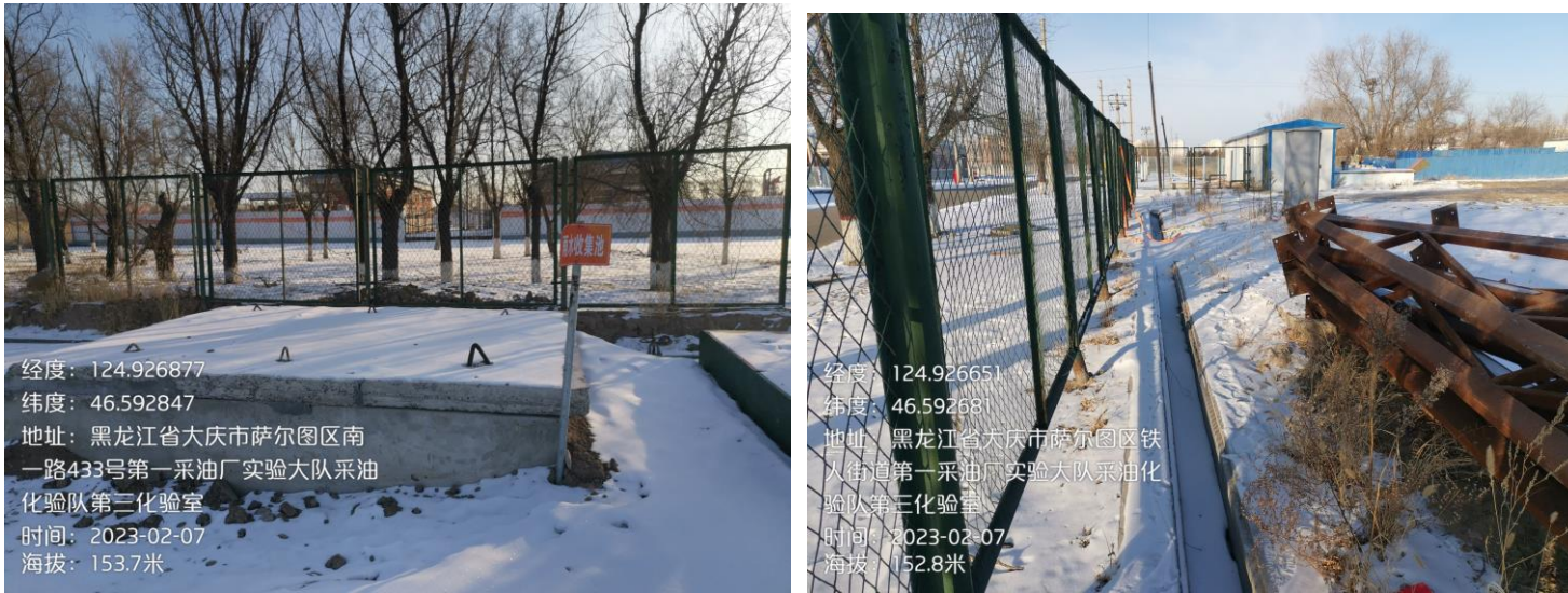
图 4-9 厂区雨水收集沟和初期雨水收集池现状
