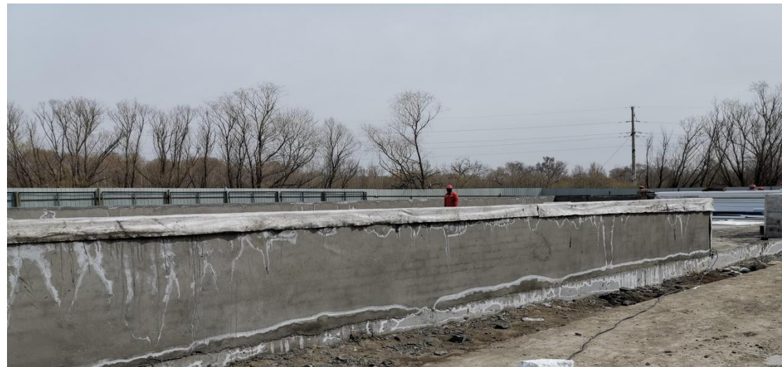
图 4-13 废液池防渗工程
