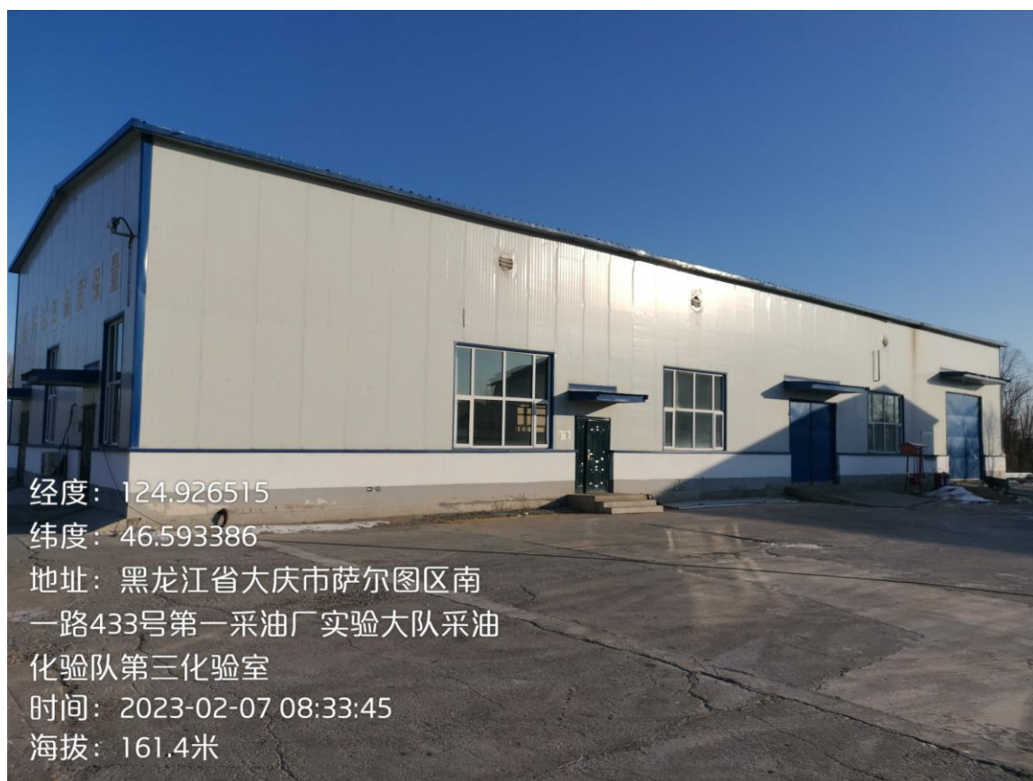
图 3-6 原有厂房现状
