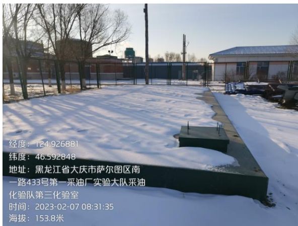
图 3-18 新建事故池现状
