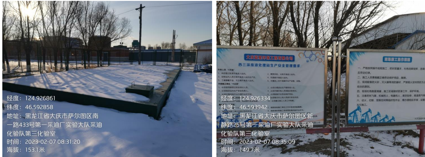
图 4-10 新建事故池现状
