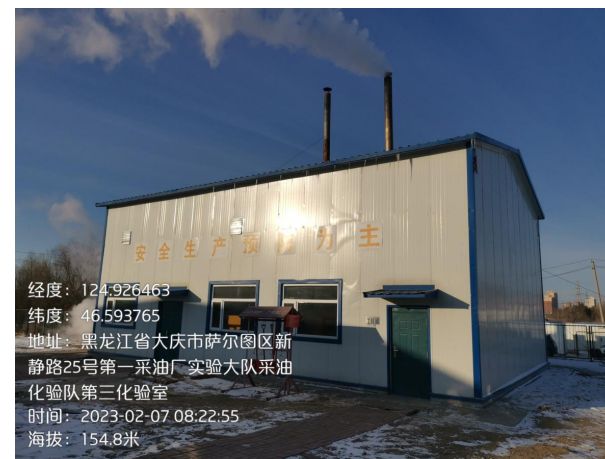
图 4-4 锅炉房烟囱现状
