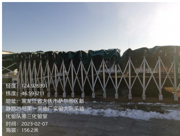
图 4-2 可移动伸缩式防晒、防雨罩棚现状
