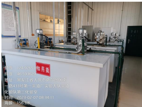
图 3-15 新建自动加药装置现状
