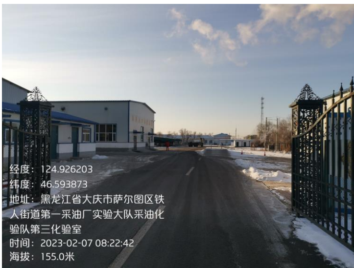
图 4-14 厂区道路硬化现状
