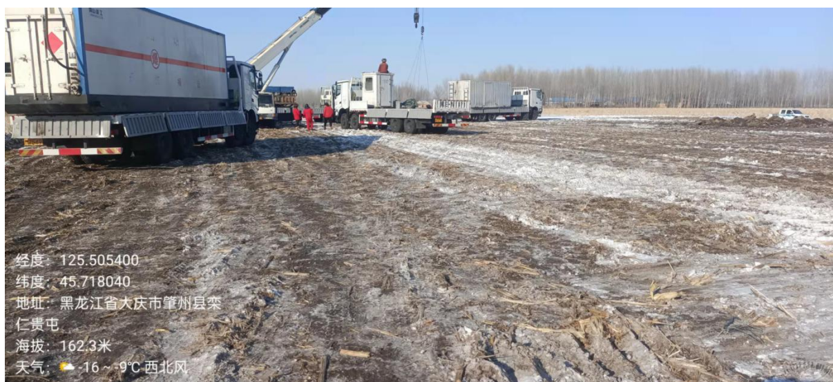
图 3.8-3 2#平台现状照片
