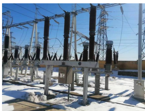
站内场地平整情况
