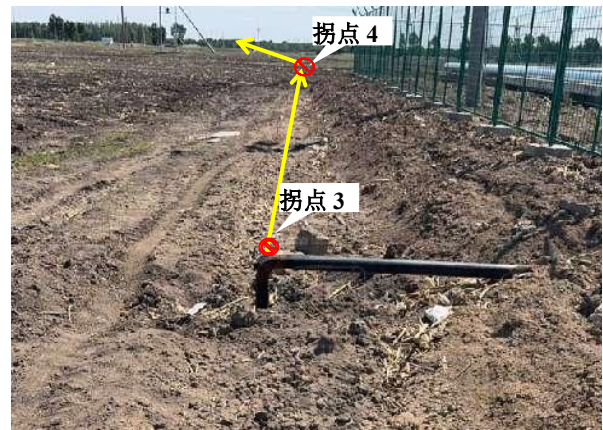
管线拐点 3 至管线拐点 4 区段临时占地恢复现状
