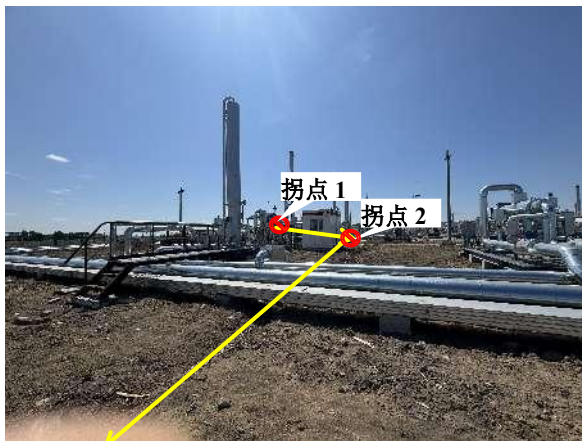
新建管线起点采气分公司肇深 16 集气站站内部现状
