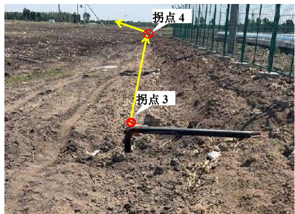
管线拐点3至管线拐点4区段临时占地恢复现状
