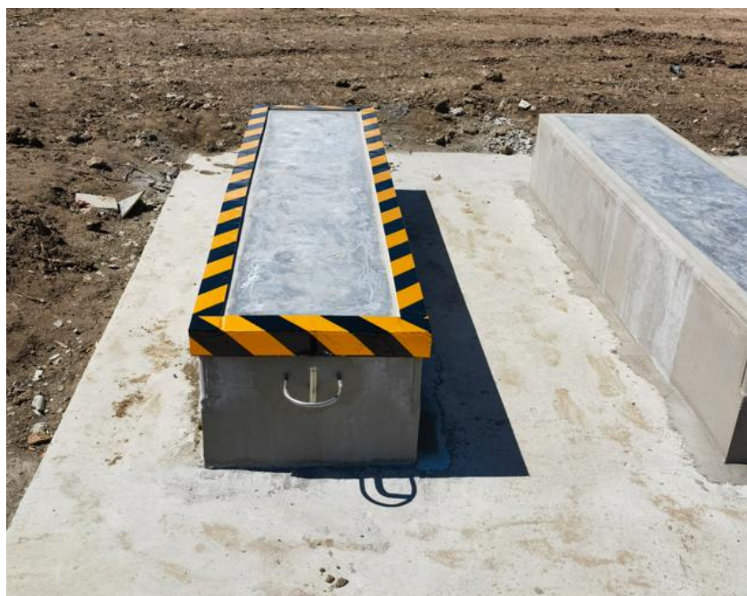
项目事故油池现状 (2024. 4)
