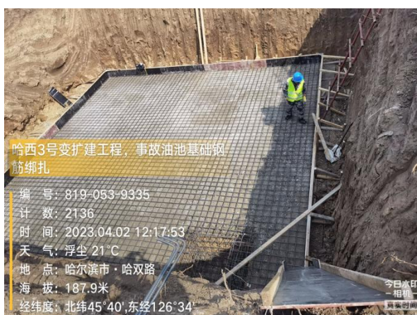
项目事故油池基础、防渗施工 (2023. 4)
