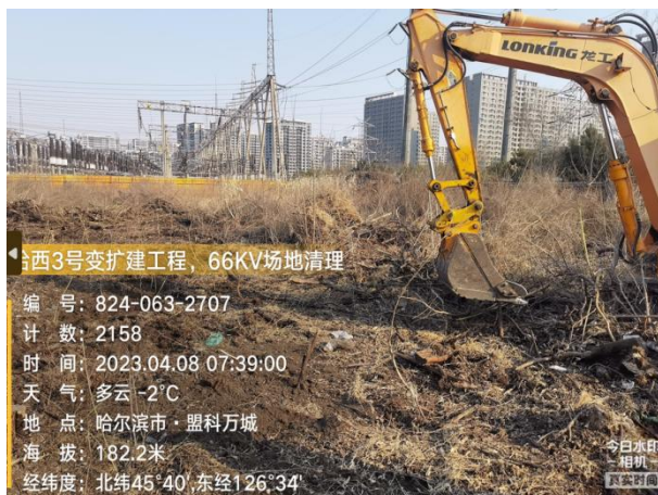
项目施工期场地平整（2023.4）
