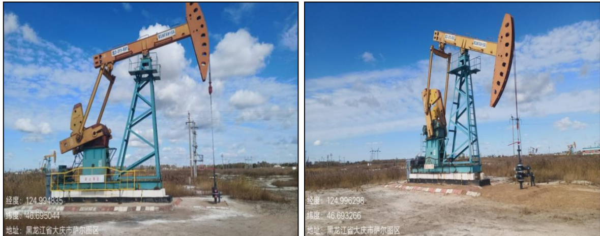
图 3.1-1 北三区西部西南块现有井场周边生态恢复情况
