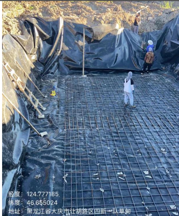
初期雨水池防渗施工
