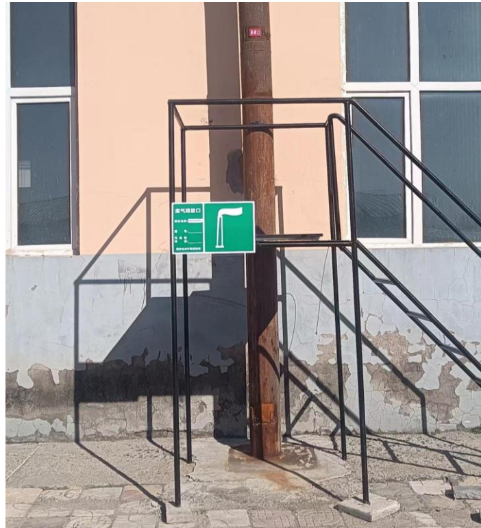
图 4-9 生产车间排放口及标识
