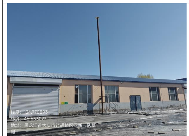
生产车间15m排气筒
