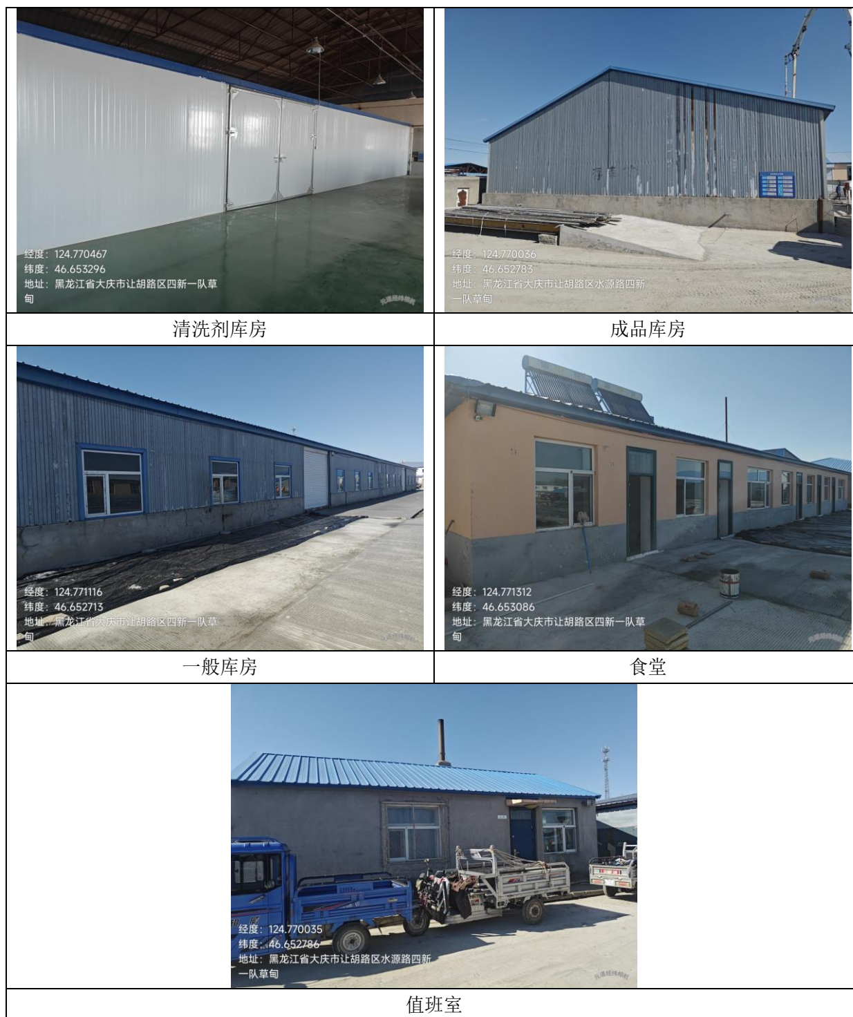
图 3-1 建筑物现场照片
