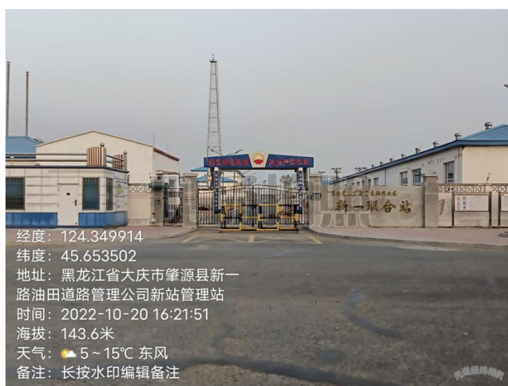
图 3.9-8 新一联合站含油污水处理站现状
