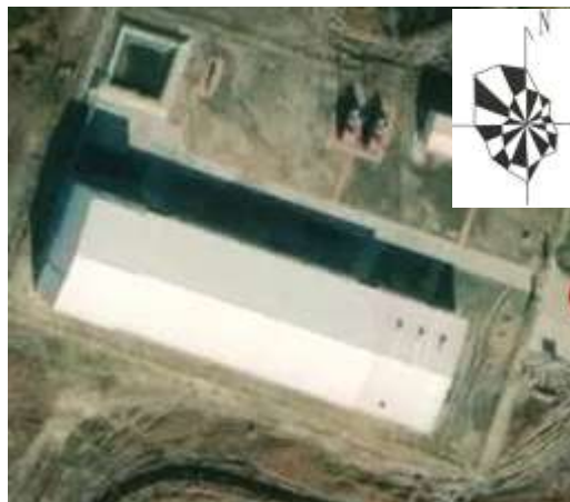
南七西工区八西二号注入站
