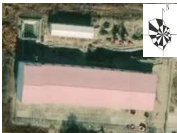
南七西工区八西一号注入站
