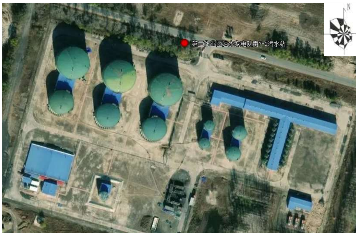
注水变电队南7-2污水站
