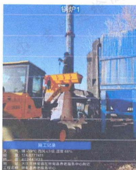
锅炉烟囱 (DA001)
