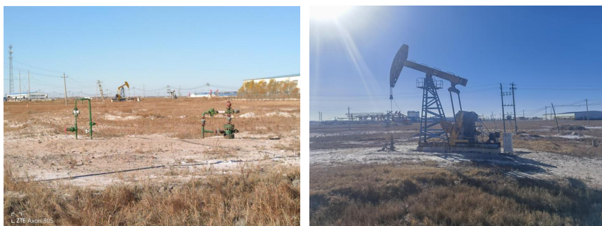
图 3.2-1 现有区块已建油水井现状
