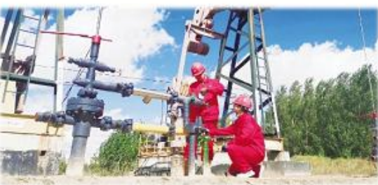
大庆油田员工在单井生产区对一口井进行检修。
