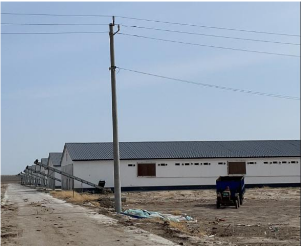
鸡舍建设现状
