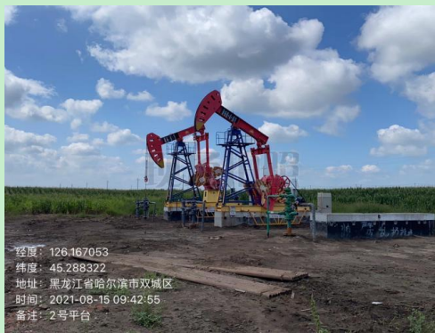
2#平台井场现状
