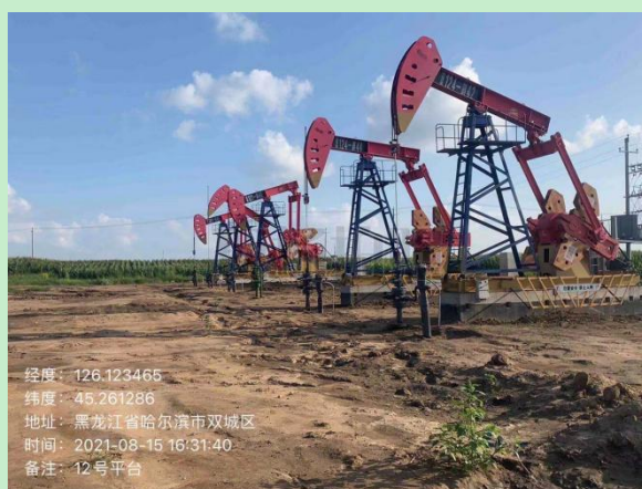
12#平台井场现状
