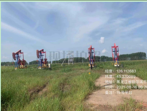
15#平台井场现状
