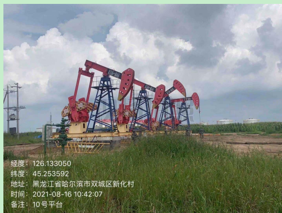
10#平台井场现状
