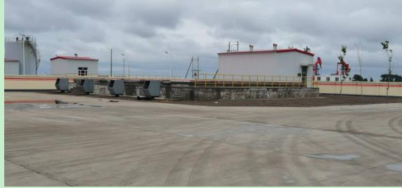
综合废液处理池现状
