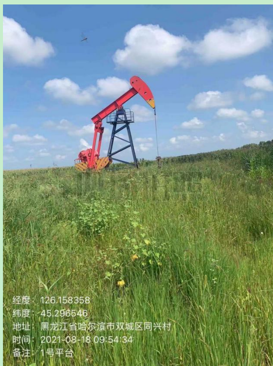
1#平台井场现状
