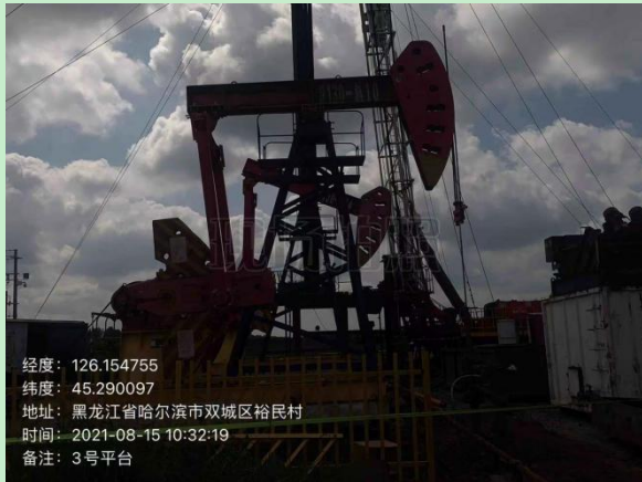
3#平台井场现状
