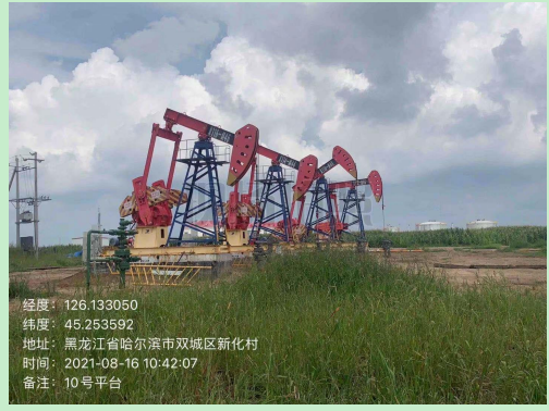
10#平台井场现状
