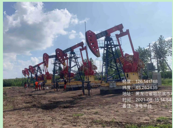
8#平台井场现状
