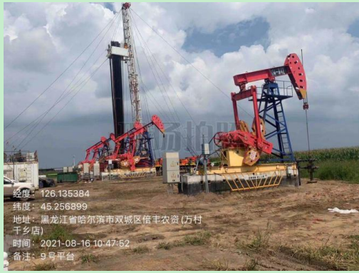
9#平台井场现状
