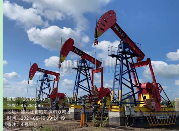
4#平台井场现状
