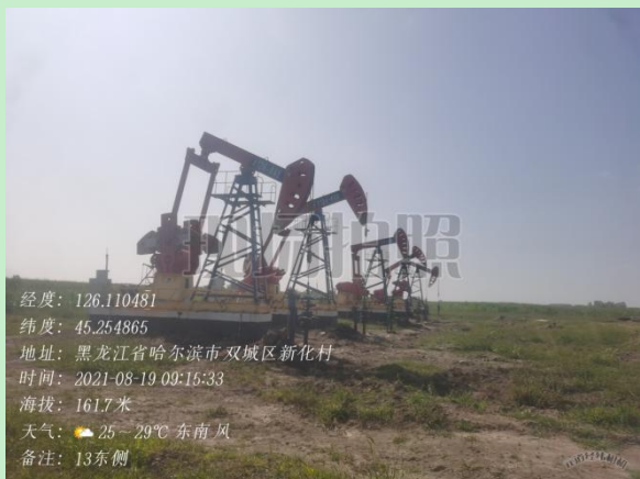
13#平台井场现状
