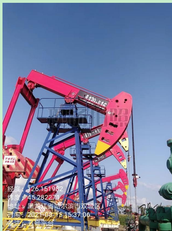
5#平台井场现状
