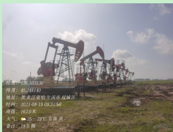
18#平台井场现状
