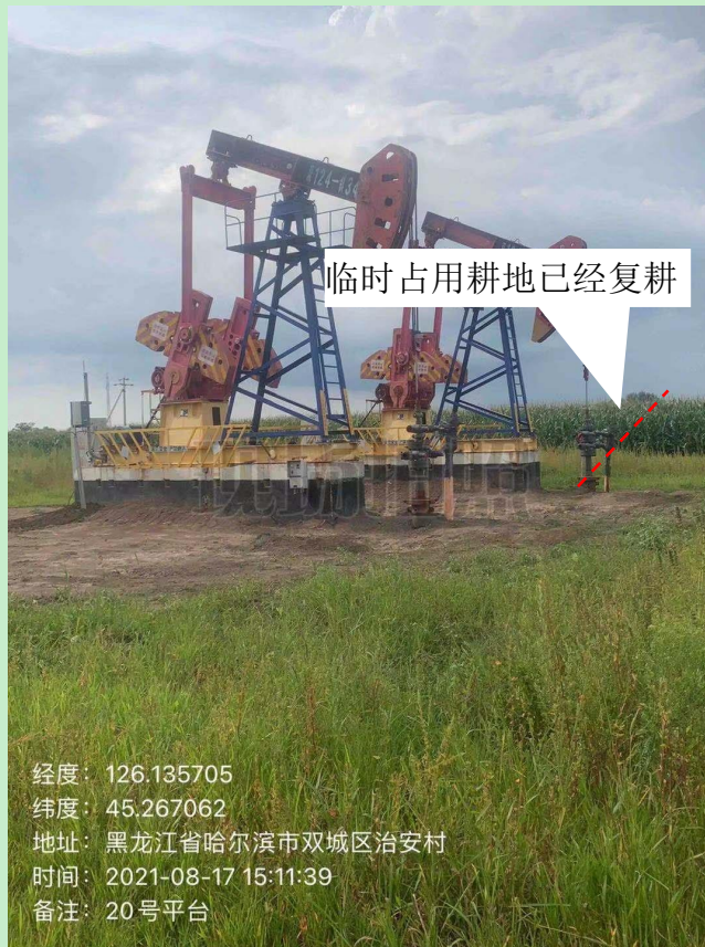
20号平台井场至双三联站内集油阀组间集油管线临时占地恢复现状
