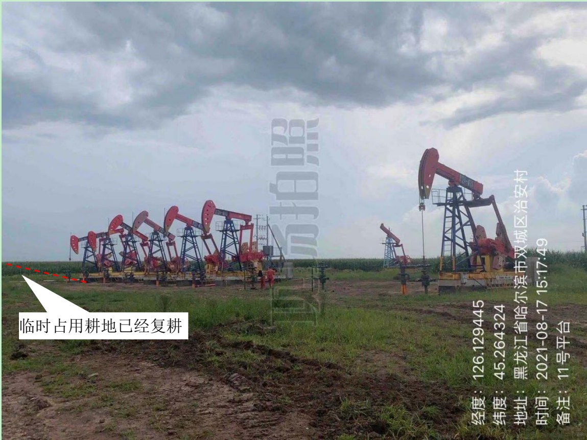
11号平台井场至3-2号阀组间集油管线临时占地恢复现状
