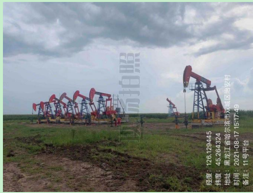
11#平台井场现状
