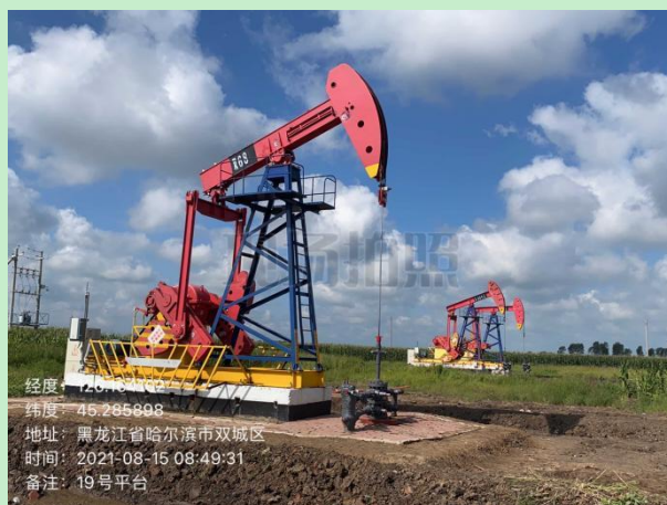
19#平台井场现状
