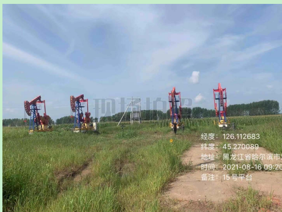
15#平台井场现状
