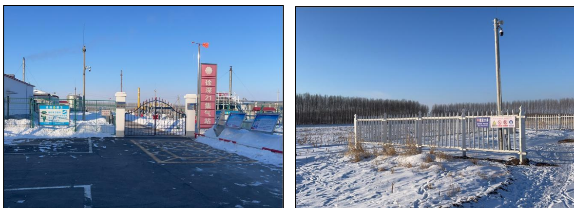
区域内已建徐深 21 集气站场地硬化现状 区域内徐深 21 井周边耕地临时占地恢复现状
