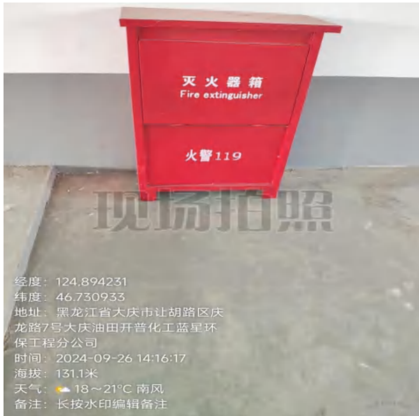
含油污泥贮存间灭火器
