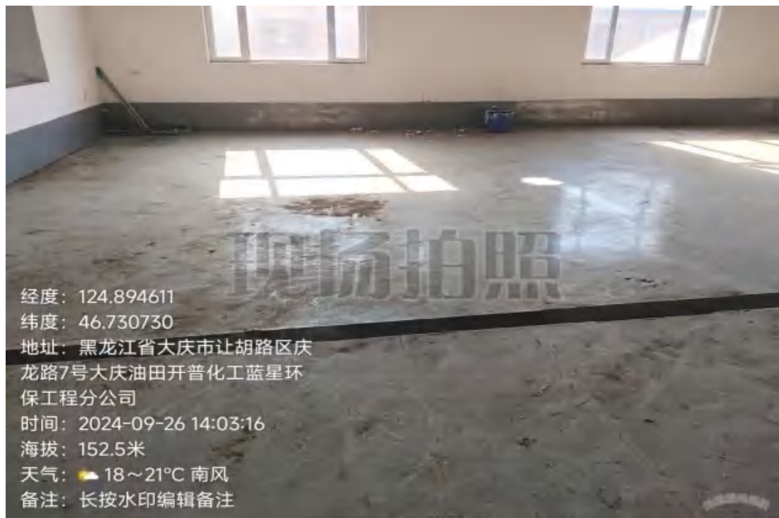
含油污泥贮存间
