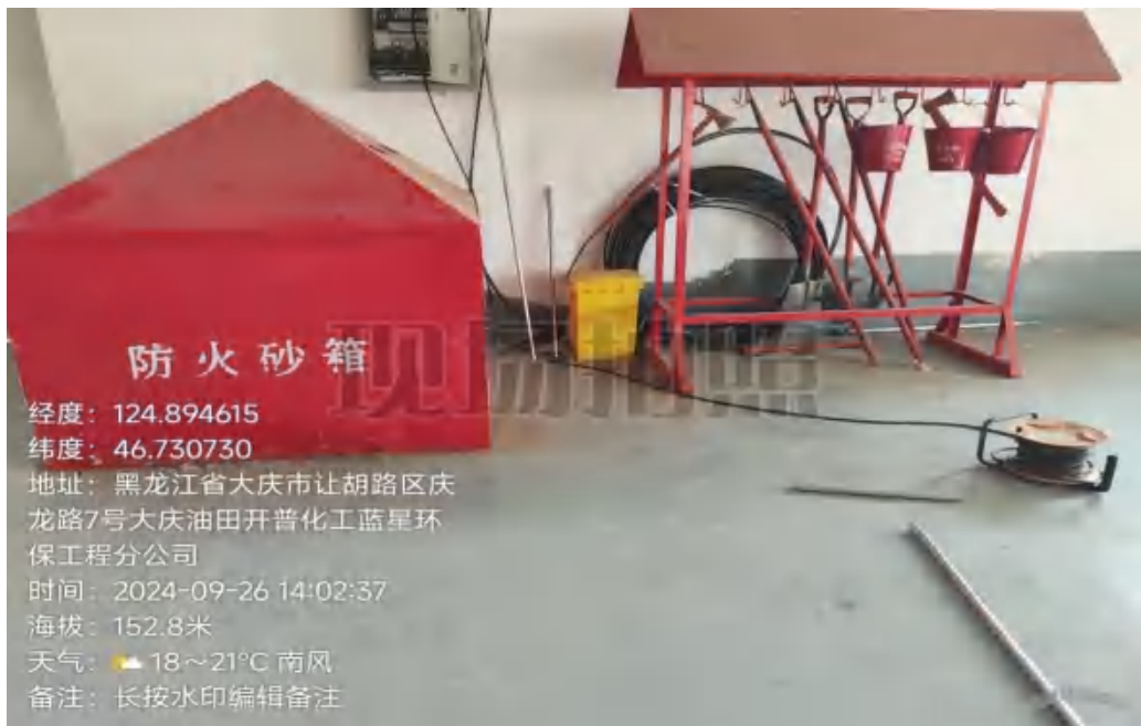
防火砂箱及消防器材
