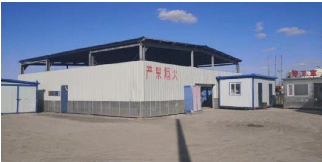
朝一联废压裂液处理站现状
