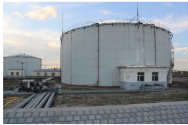
朝一联合站罐区现状
