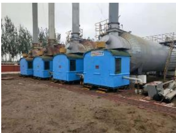
朝四联转油站加热装置区现状
