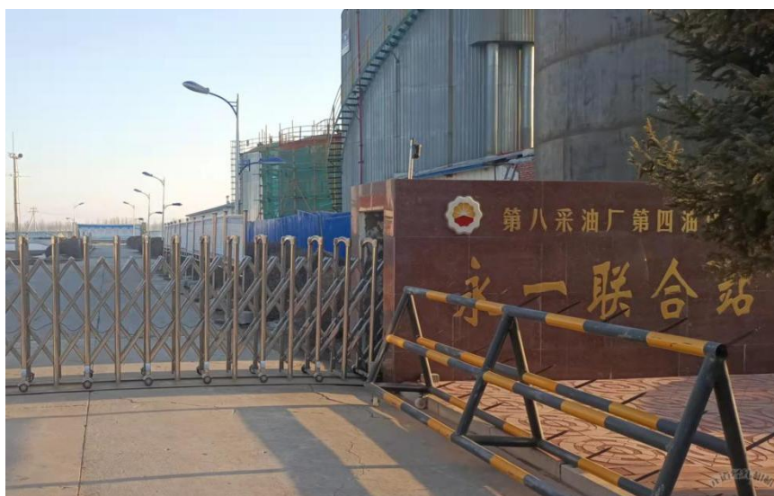
图 3-3-1 永一联合含油污水处理站现状
