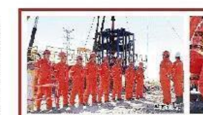
葡7-4-P2130井顺利完成11层段定点改造。
