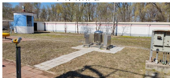
扎地管线恢复现状
