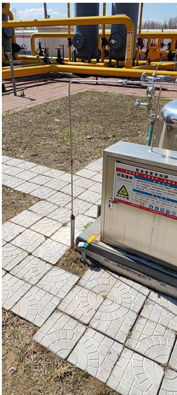
扎地管线恢复现状
