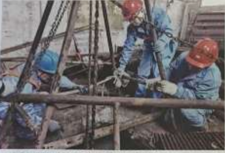
采油七厂工作人员正在对二氧化碳驱油采收率提升技术进行现场操作。
