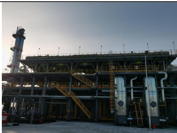
一级、二级、三级增压机出口空冷器
