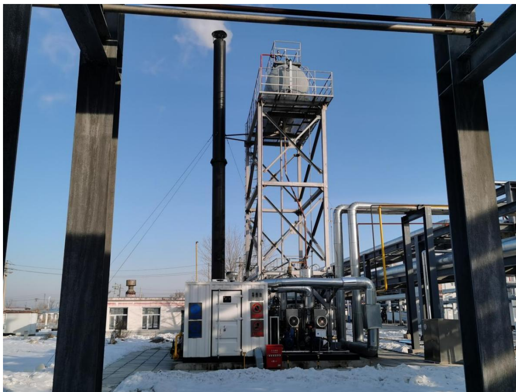
图 3-1 导热油炉加热炉排气筒
