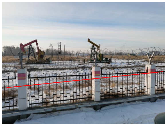
改造集气管线
