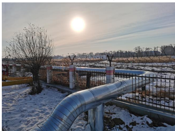
改造集气管线入口
