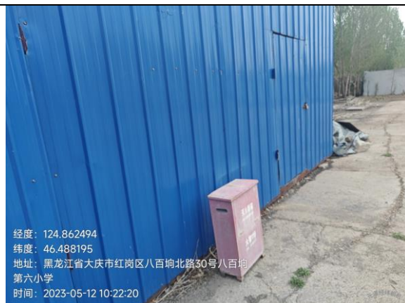
危废暂存间灭火器箱
