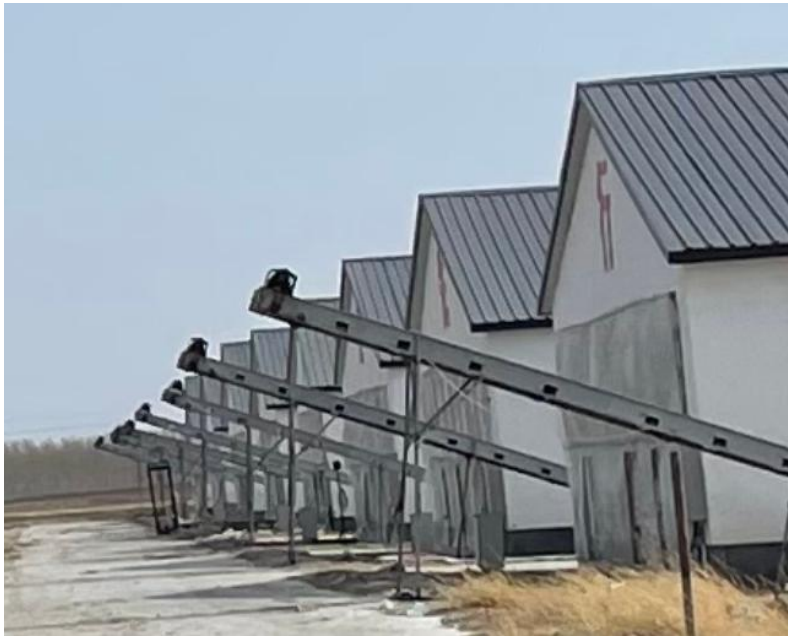
鸡舍建设现状
