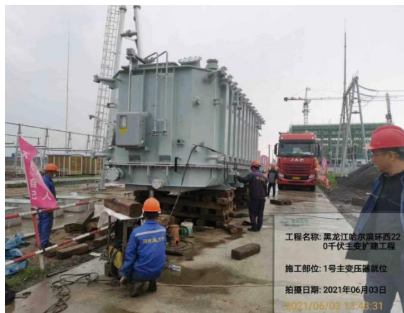
本次拆除主变施工照片
