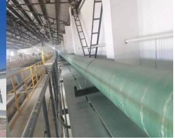
除臭间（除臭装置、集气管道、排气筒）
