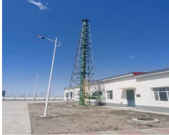
除臭间（除臭装置、集气管道、排气筒）
