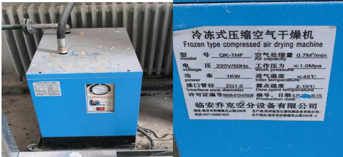
冷冻式压缩空气干燥机
