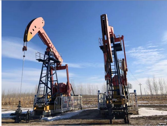
2#平台井场现状
