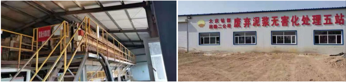
撬装废弃泥浆处理站现状
