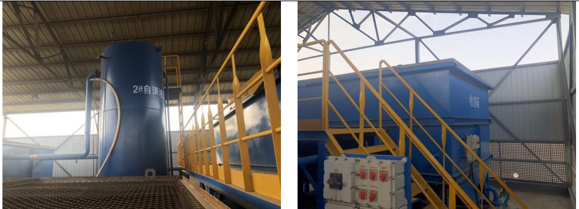
宋二联废压裂液无害化处理站现状
