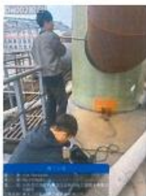
DA002 排气筒处理前
