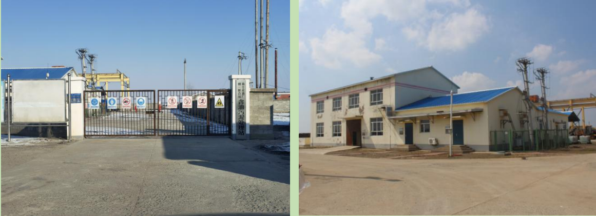
图 3.10-4 朝一联合含油污泥处理站现状
