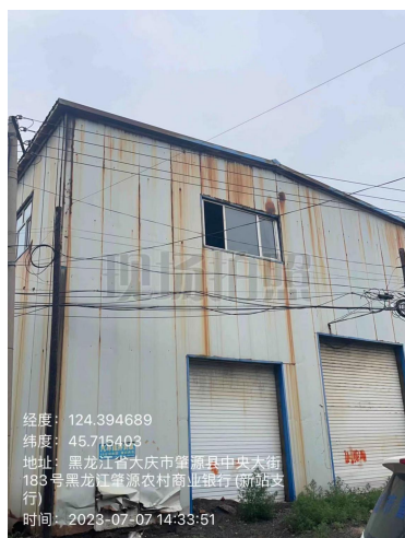
祥和锅炉房现状
