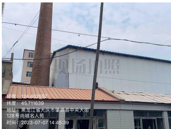
耐火砖厂锅炉房现状
