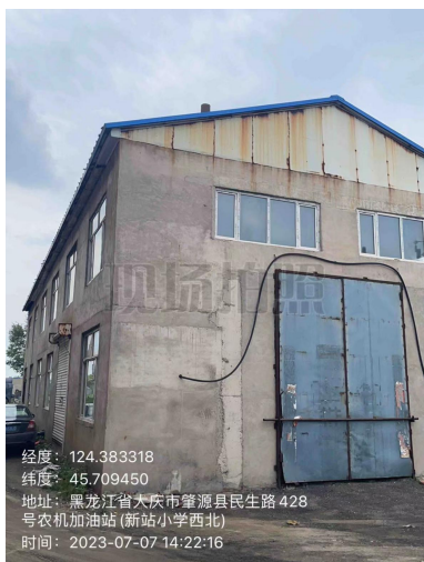
苗圃锅炉房现状
