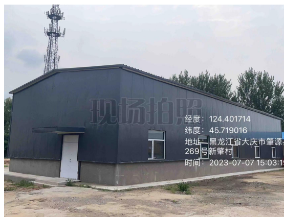
新站林场锅炉房现状
