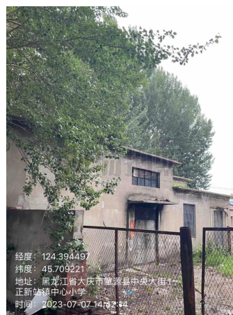
灾民楼锅炉房现状
