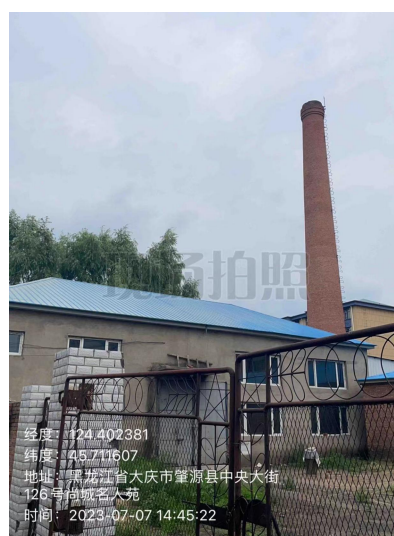
工商行锅炉房现状
