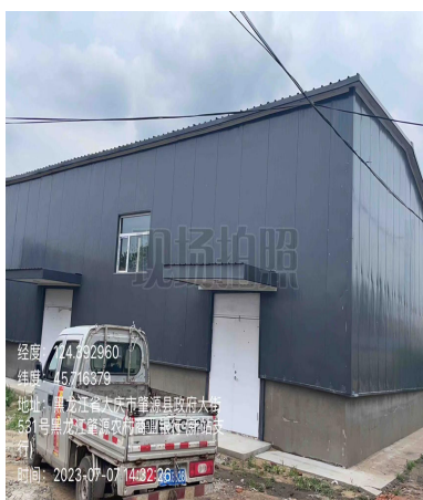
荣昌商都锅炉房现状
