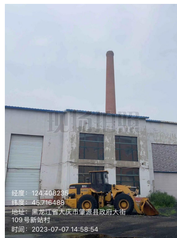
鸿运新城锅炉房现状
