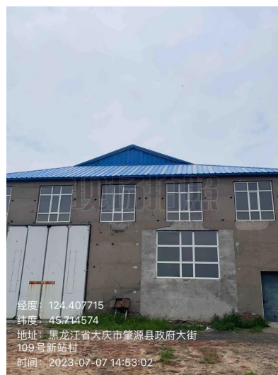
同鑫锅炉房现状
