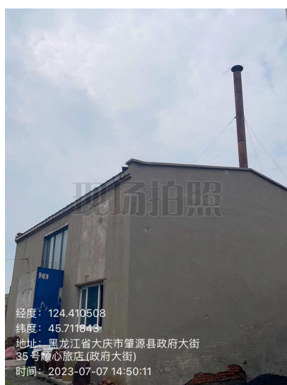
锦绣佳苑锅炉房现状
