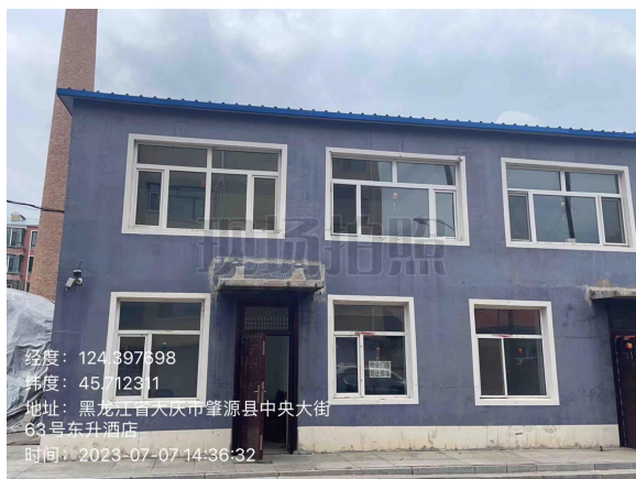
世纪佳苑锅炉房现状
