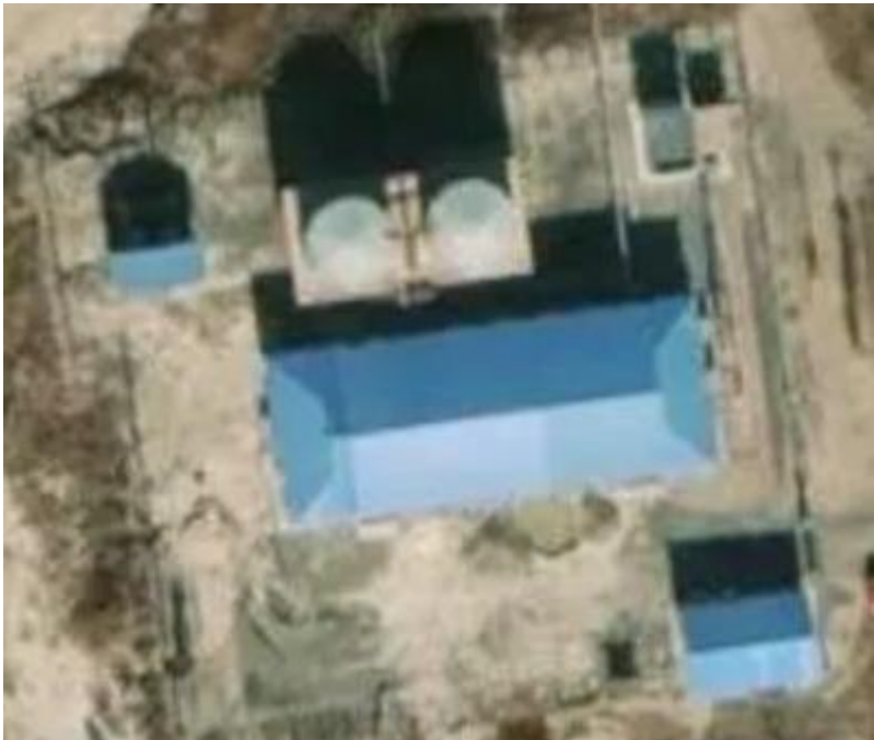
南三东 3 号注入站
