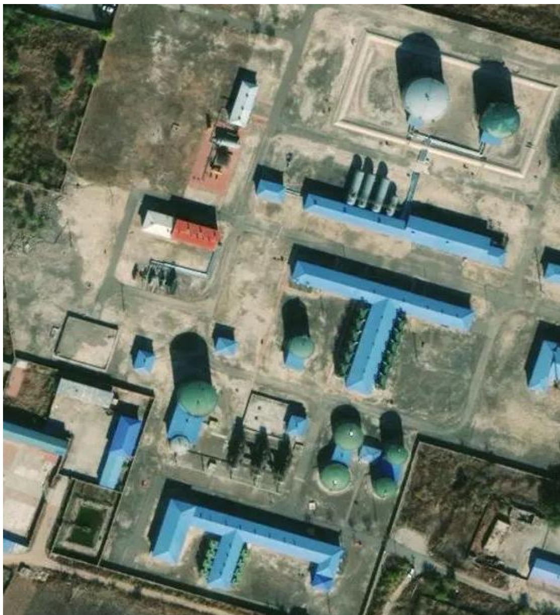
南十联放水站
