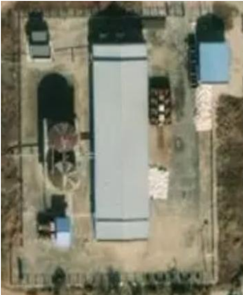
南二东 4 号注入站
