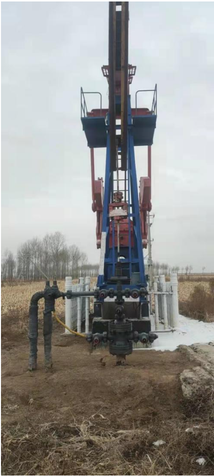
已建卫 2-56-27 井场恢复现状
