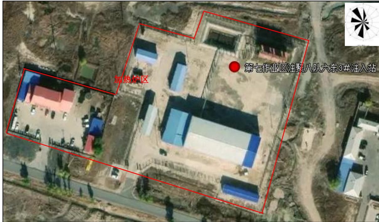
注聚八队六东 3 # 注入站
