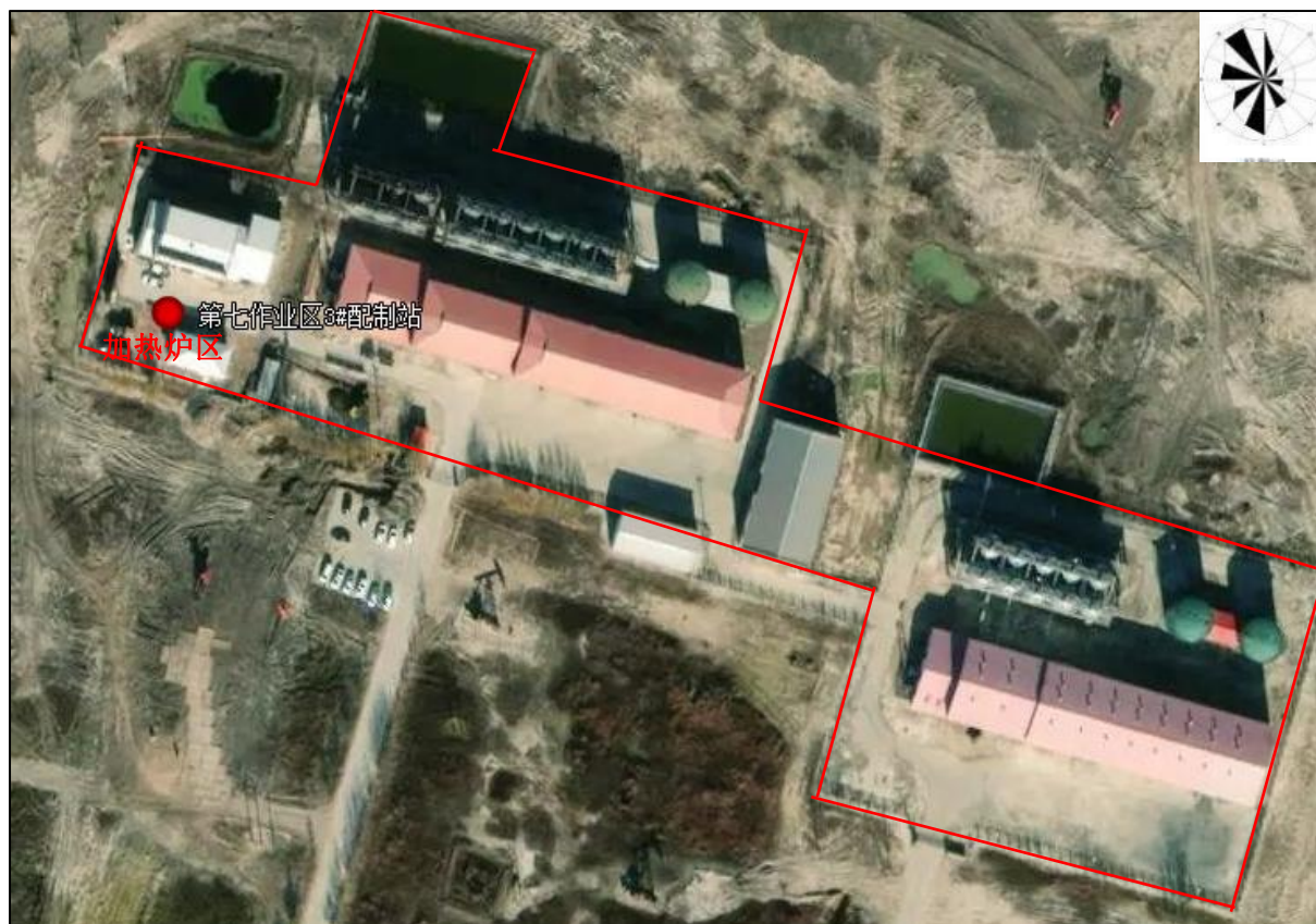
第七作业区 3#配制站
