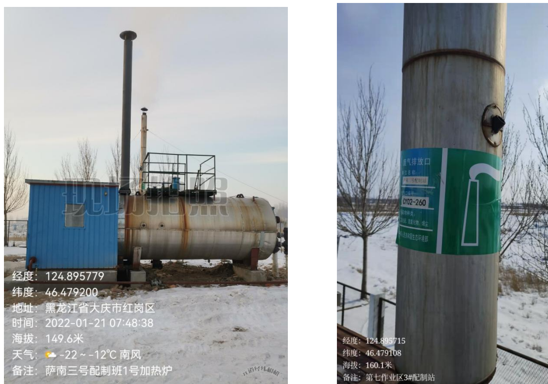
图 3-2 第七作业区 3#配制站 1#加热炉烟囱现状
