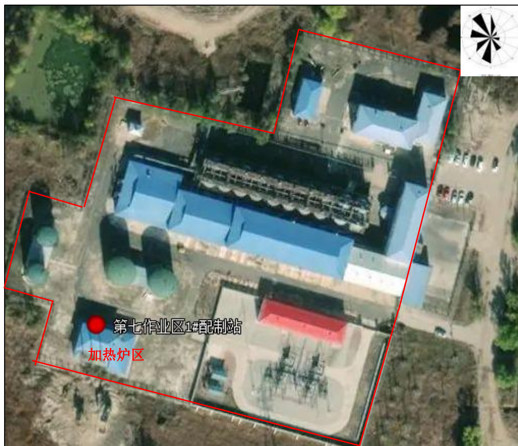
第七作业区 1#配制站
