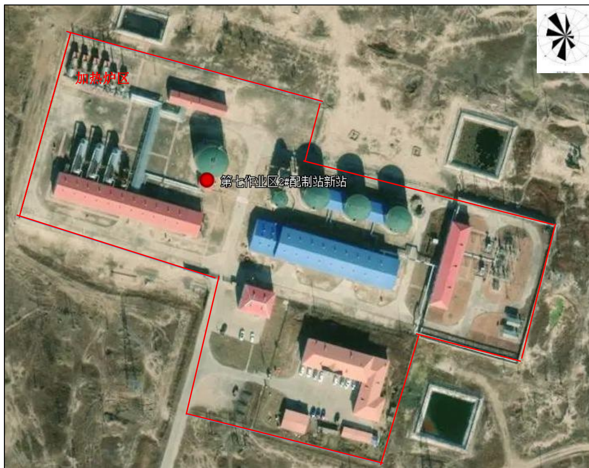
第七作业区 2#配制站新站
