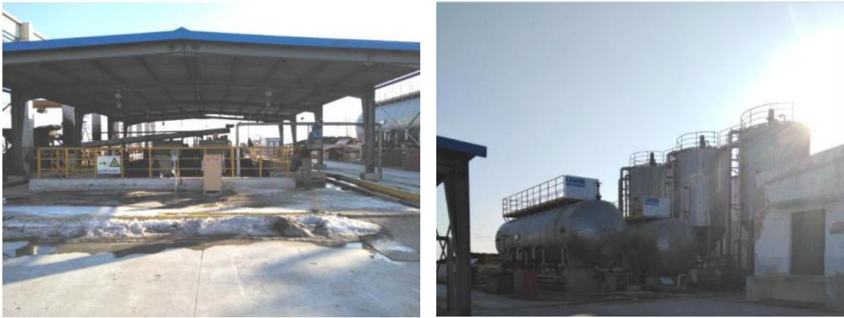
图 3.9-6 杏 V- II 含油污泥处理站现状图
